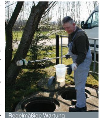
Regel sind 1-3 Wartungen pro Jahr erforderlich, bei denen die Anlage und alle maschinentechnischen, elektronischen und sonstigen Anlagenteile inspiziert werden. Neben der Reinigung wird auch die Wirksamkeit der Anlage geprüft und in einem Wartungsprotokoll festgehalten.
